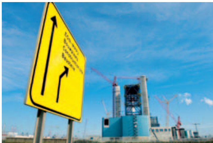
Op de Maasvlakte wordt naast de bestaande kolencentrale van E-on een nieuwe kolencentrale gebouwd
